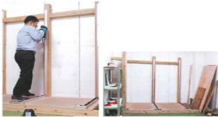
壁レール取付
